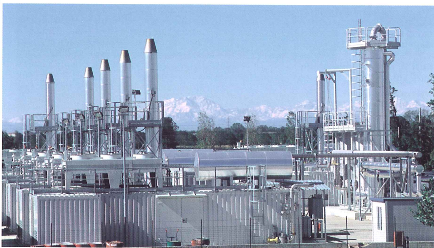
2 - MESBG-EC: MARCOPOLO Ecotone System BioGas & Electric Cogeneration Impianto di captazione, trasporto, analisi, controllo e trattamento del biogas da discarica con produzione di energia elettrica e termica
